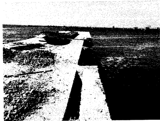
Fotografía N°04: demolição de viga mandil de muelle existente.
