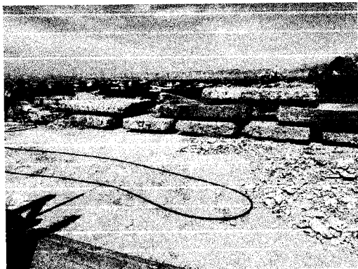
Fotografía N°03: demolição de losa de muelle existente.
